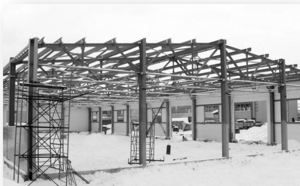
Рисунок 1. Ангар со стальным несущим каркасом
